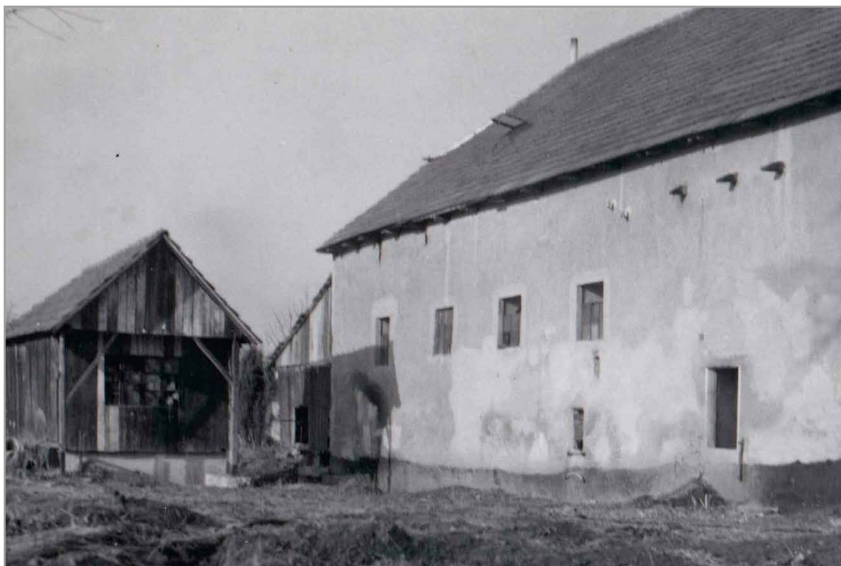
Budova bývalého mlýna č. p. 51 v Hradčovicích
