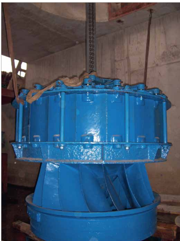
Opravitelné turbíny se znovu uváděly do provozu
