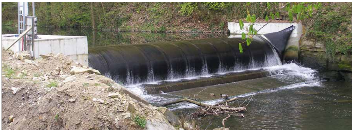
Vzdouvací objekty u MVE zadržují významně vodu v jezových zadržích v korytech vodních toků a tím i v naší krajině
