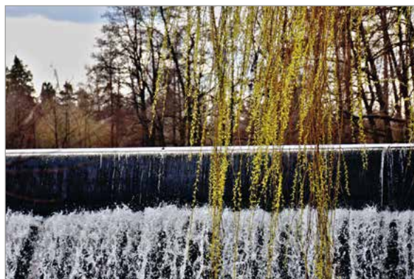
V ČR jsou stále lokality s již soustředěným spádem bez energetického využití
